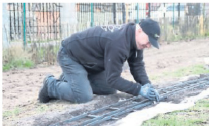
Die dreigleisigen Schienen haben die IG-Mitglieder selbst gefertigt und fünf Tonnen Flachstahl verbaut. Fotos (3): Schwarze
